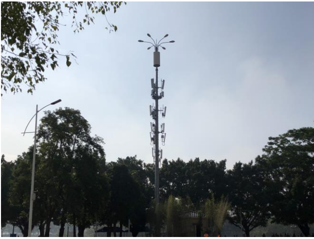
图1：中国铁塔地面塔站
