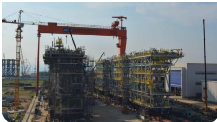
图26、炼油厂模块建设
