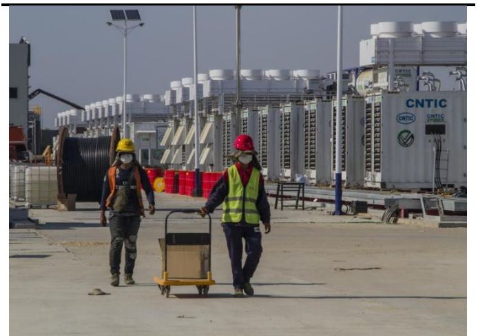
图 4: 伟能合营公司在 Thekata 地区的 400MW 项目蓄势待发
