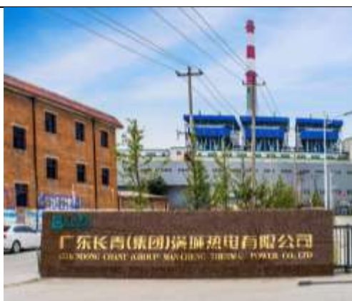
图 34: 满城热电联产项目
