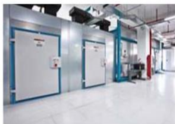
EMC实验室（外部）
