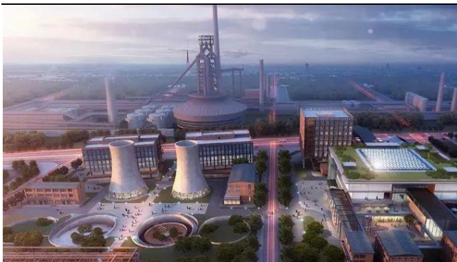
图7 首钢六工汇项目
