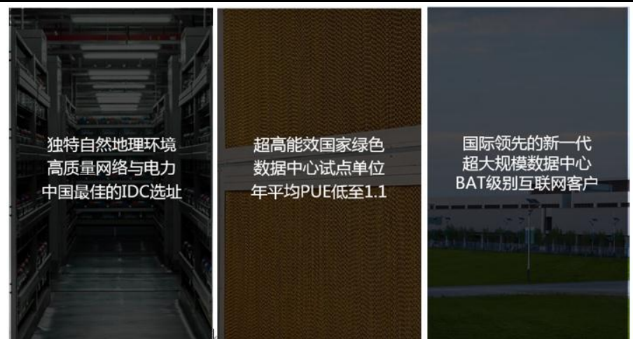
图 35: 宁夏誉成云基础数据中心兼具超高能效和超低能耗
