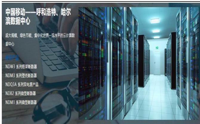
图32: 中国移动数据中心项目
