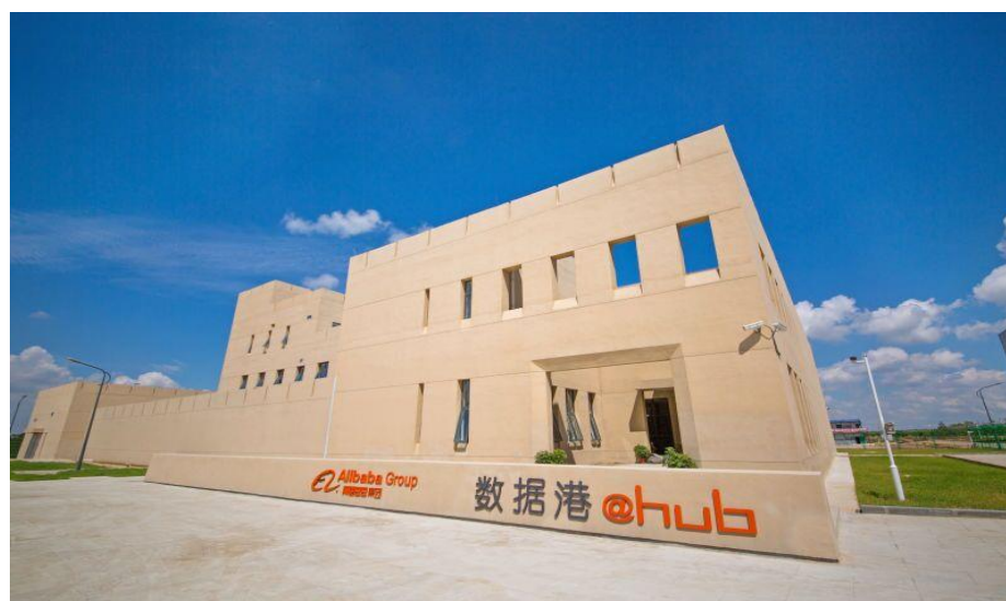
图表24： 数据港同阿里合作的张北数据中心项目
