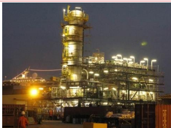
海水淡化处理模块/SRU 模块
