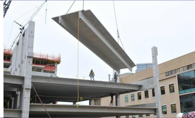
图表 22：混凝土预制件吊装过程
