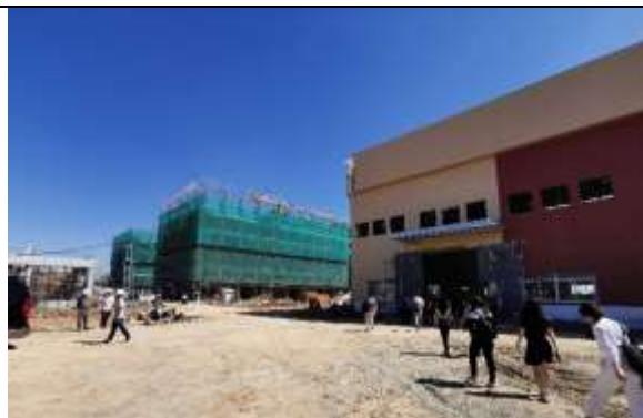
图 2：柬埔寨新项目在建厂房外部
