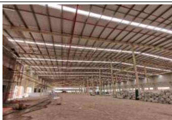
图 3：柬埔寨新项目在建厂房内部
