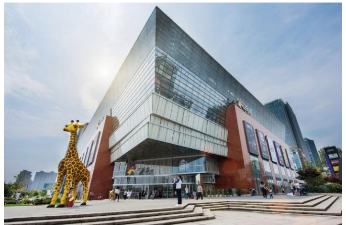
图 45：上海长风大悦城是收购存量物业改善翻新的购物中心
