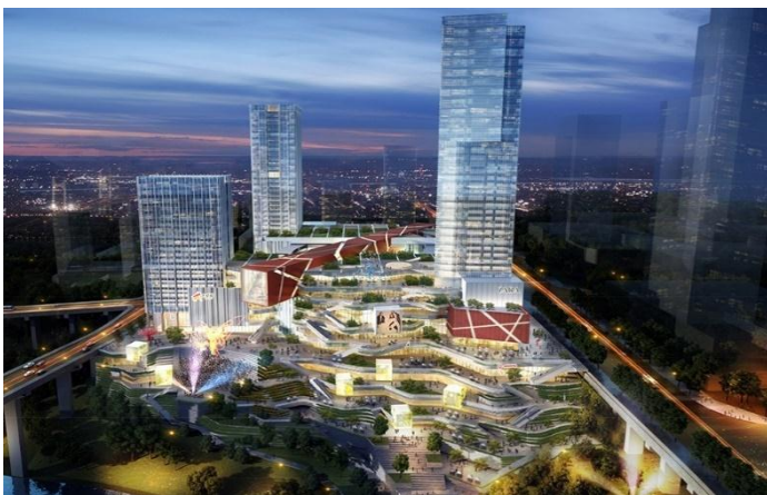
图 44：重庆大悦城是通过拿地-设计-建设的购物中心项目
