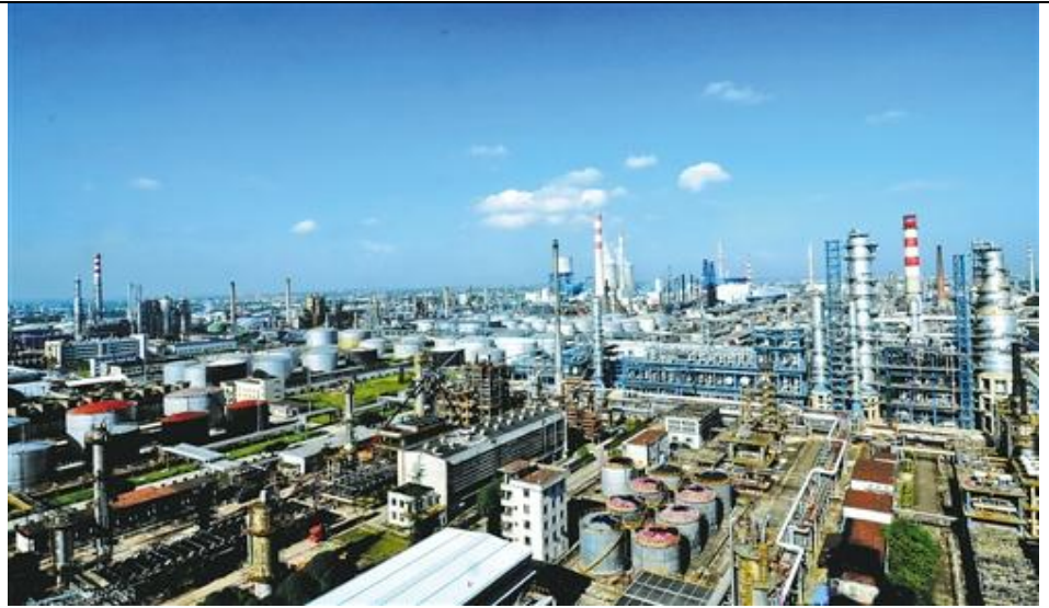
图 31：中科炼化一体化项目装置区
