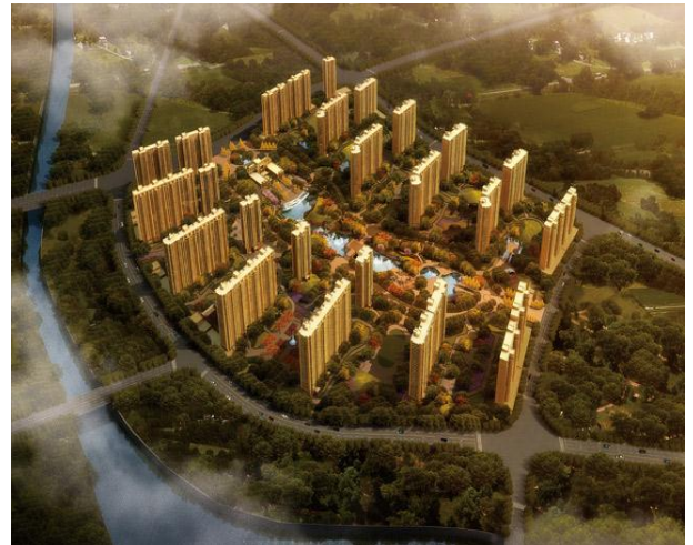
图 38: 杭萧钢构参与包头万郡大都城项目
