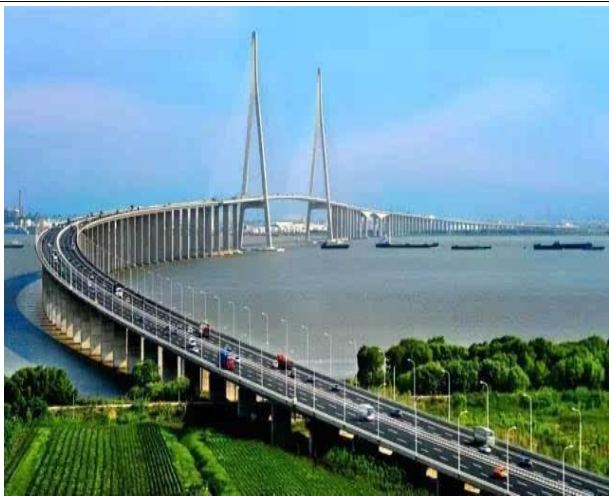
图 41: 苏通大桥是典型的特大型公路桥
