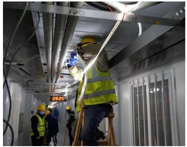
图 11：装配化施工方式做到各道工序可同步开展
