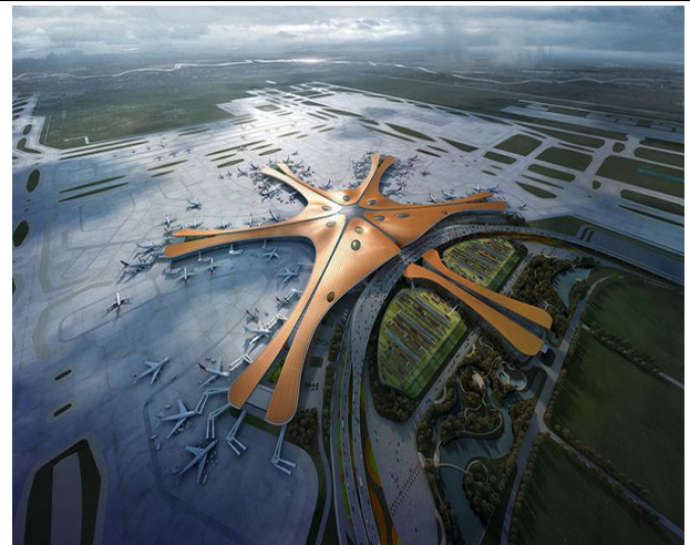
图 27: 精工钢构参与北京大兴机场航站楼项目
