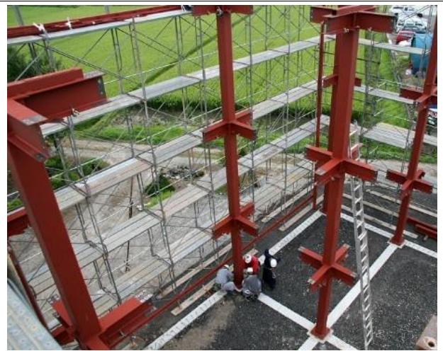
图 15: 装配式钢结构作业方式非常环保
