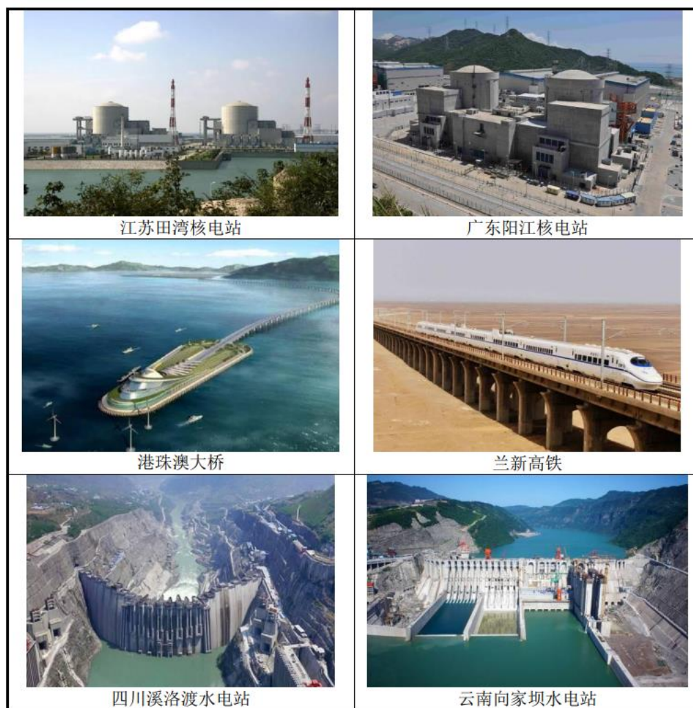
图 7：公司产品部分应用工程
