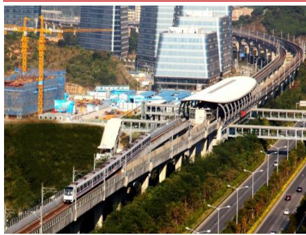
图 47：中国中铁参建的深圳地铁五号线项目
