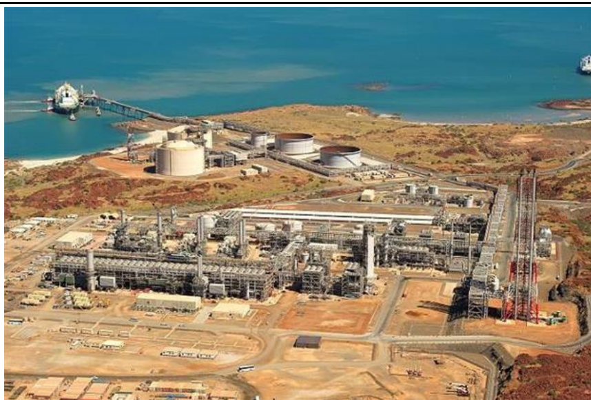
图 29: 天然气液化工厂中的核心部分采用模块化的建造方式
