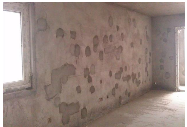
图 181：水泥抹灰由于水泥材料特性易于空鼓、开裂
