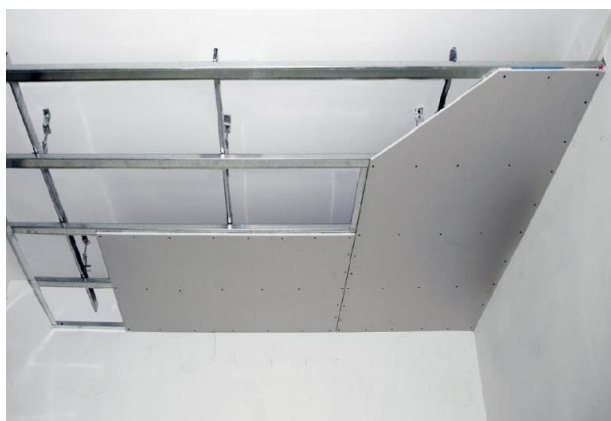
图 169：吊顶用轻钢龙骨
