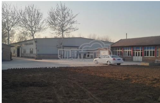
图 21: 某典型低标仓: 某工业园区配套的小型仓库
