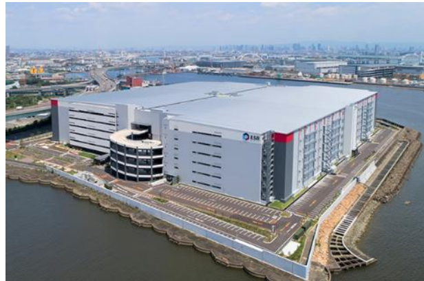
图 38：公司建设的亚大区最大单体仓储项目-尼崎配送中心
