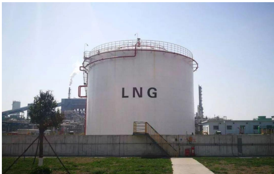
图 42：天津南港 LNG 储罐
