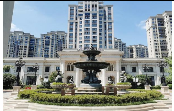
图26 杭州世茂智慧之门实景图
