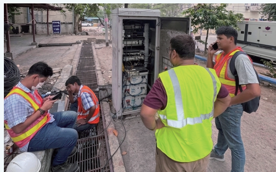
华为团队第一时间赶赴缅甸地震灾区，对通信业务进行应急恢复。
