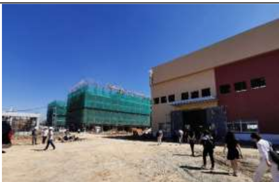
图 2: 柬埔寨新项目在建厂房外部
