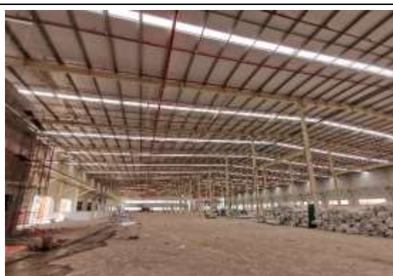
图 3: 柬埔寨新项目在建厂房内部
