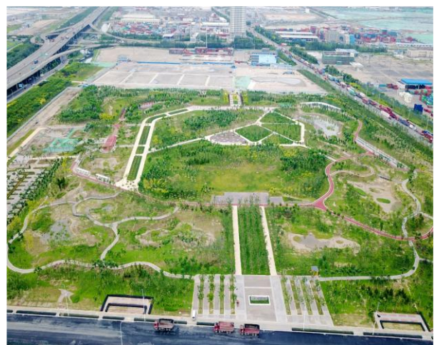
图 17：天津 8·12 爆炸事故现场（修复后）
