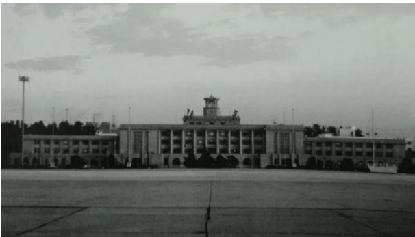
图 1：1958 年北京首都机场航站楼
