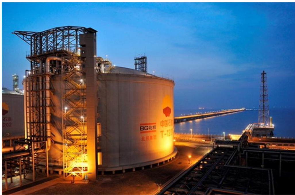
图13、唐山曹妃甸 LNG 接收站
