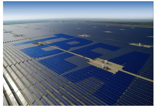
图 4: 公司承建巴基斯坦 100MW 光伏电站
