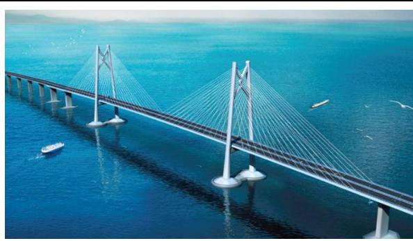
图19 采用钢箱梁的港珠澳大桥
