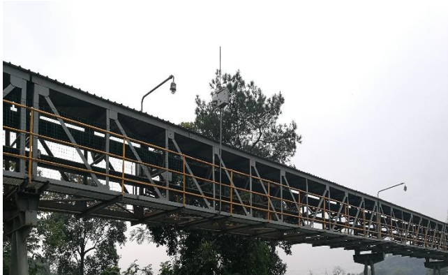
图表7：中铝广西铝土矿皮带传输装置
