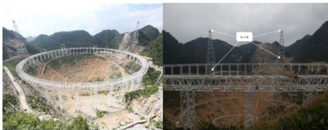
图表 26 安方高科承建国家天文台电磁屏蔽室项目现场
