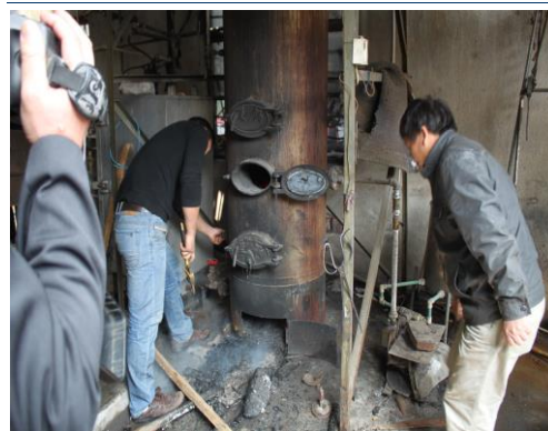
图 14：拆除小锅炉执法行动
