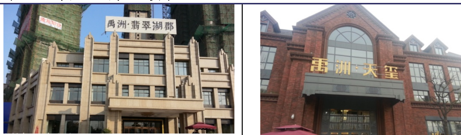
图 4、公司合肥主要项目实景
