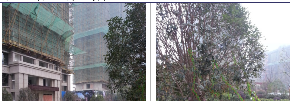
图 5、公司合肥主要项目实景
