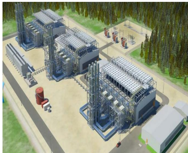
图 4: 葛洲坝能源重工制造分布式能源系统和设备
