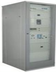
图 12: 烟气排放连续监测系统
