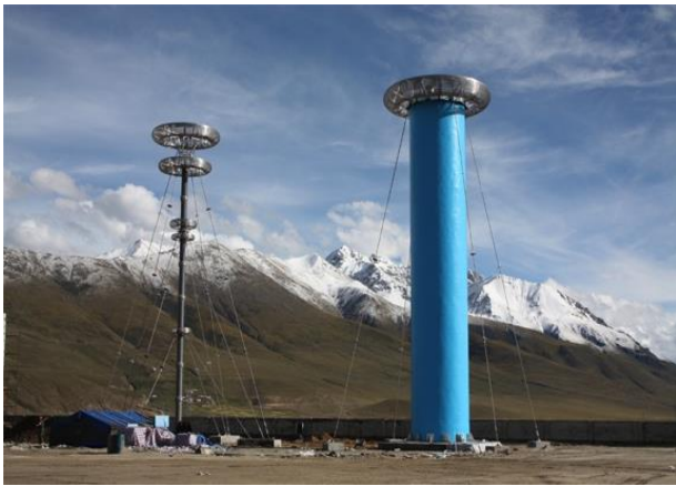
图 30: 华天机电公司的冲击电压发生器
