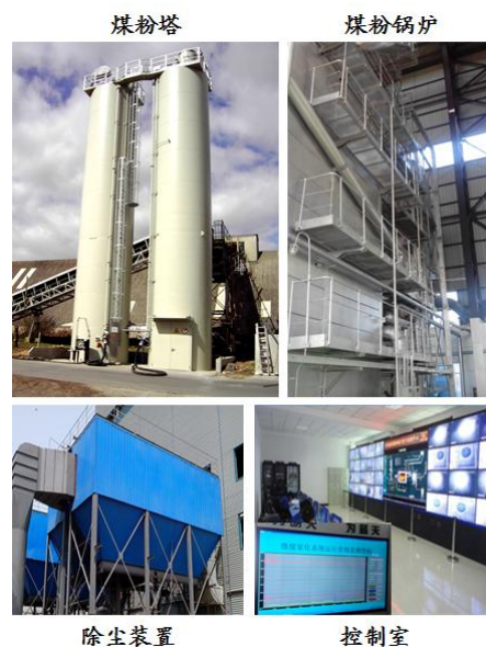
图 9：煤粉锅炉蒸汽中心照片
