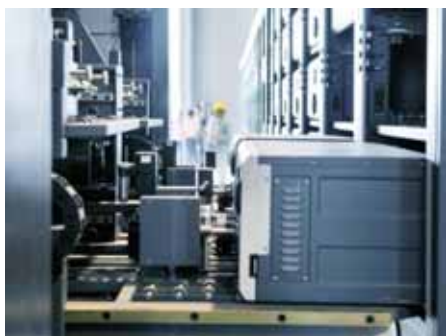
图表23 电池箱机器人快换设备
